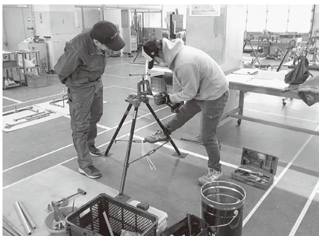
建築配管作業
